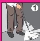
**1** Подготовьте основание. Удалите с него ослабляющие сцепление вещества: масляные и битумные пятна, пыль и прочие загрязнения. Отслаивающиеся участки удалите стальным шпателем. Обработайте основание грунтовочными составами БОЛАРС, соответствующими Вашему типу поверхности.
