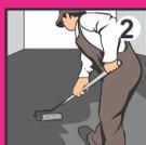
**2** Для создания впитывающего слоя, нанесите на подготовленное основание самовыравнивающую смесь для пола БОЛАРС слоем 2-3 мм. Укладка напольного покрытия непосредственно на загрунтованное основание не рекомендуется.
